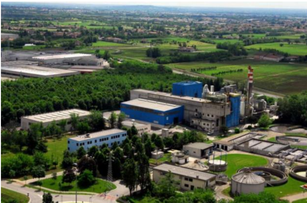
Veduta aerea dell'inceneritore – Fonte : Alto Vicentino Ambiente
